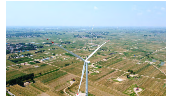
中国石化首个百兆瓦级陆上风电项目 ——中原油田 112 兆瓦风电项目
