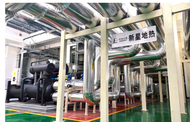
天津南港乙烯冷暖双供项目
