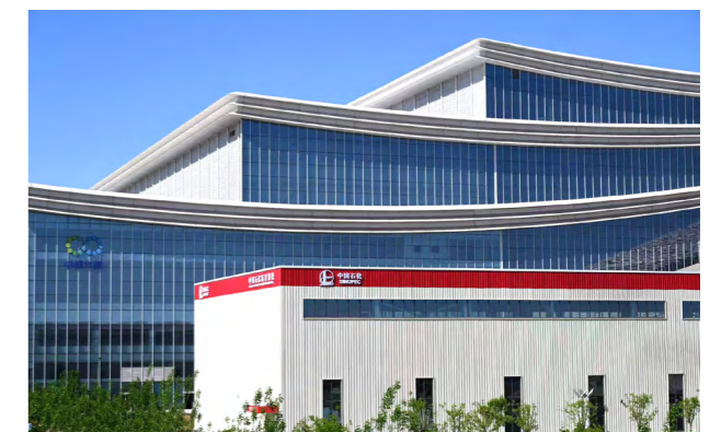
天津东丽国内首个垃圾焚烧电厂“地热+余热”梯级利用供热项目
