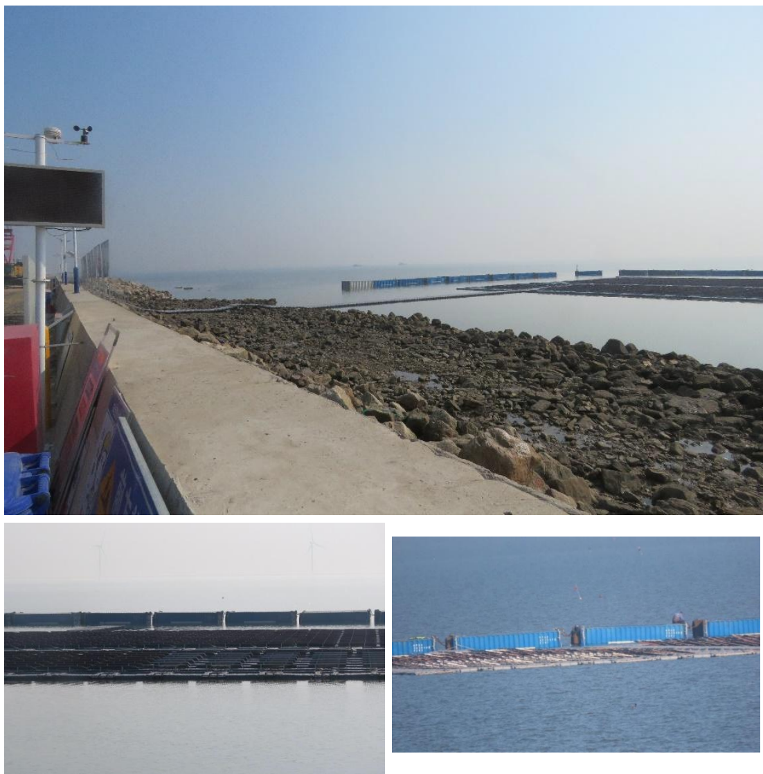
图 5.12-1 光伏先导试验场地
