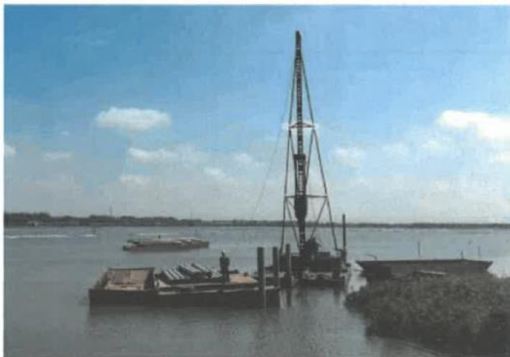
图 4.1-11 预应力管桩（锚固桩）
