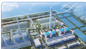
清潔高效熱電聯產機組開工
