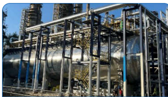
三級電脫鹽改造項目順利投用
