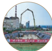
热电机组改造工程
